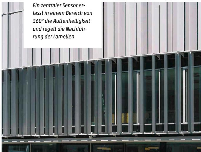
Ein zentraler Sensor erfasst in einem Bereich von 360° die Außenhelligkeit und regelt die Nachführung der Lamellen.
