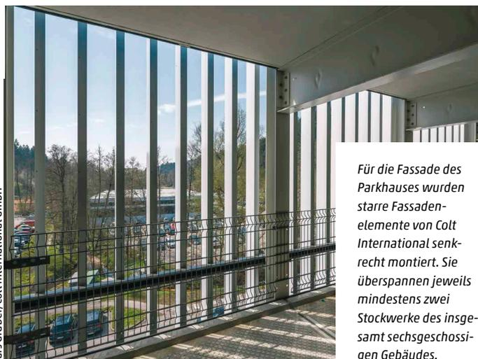
Für die Fassade des Parkhauses wurden starre Fassadenelemente von Colt International senkrecht montiert. Sie überspannen jeweils mindestens zwei Stockwerke des insgesamt sechsgeschossigen Gebäudes.
