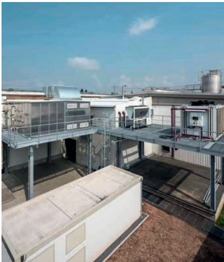
Maschinenkühlung mit einem adiabatischen Rückkühler.
