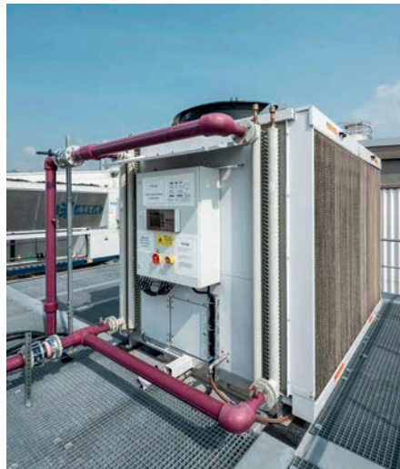
Der Trockenkühler ist Teil der Kaltwassererzeugung für die Kühlung.
